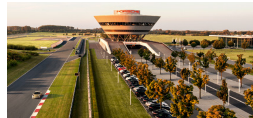
Circuit et Centre Clients Porsche
